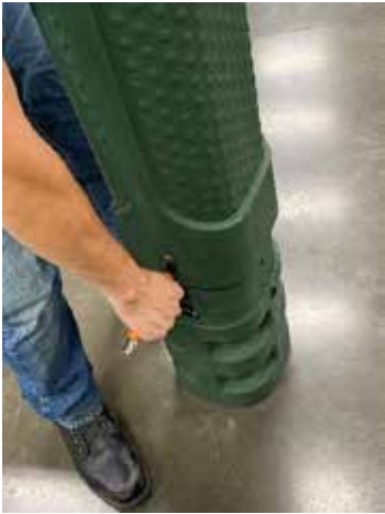
Figura 8: Manteniendo la posición desbloqueada, levante la tapa del pedestal de fibra.
