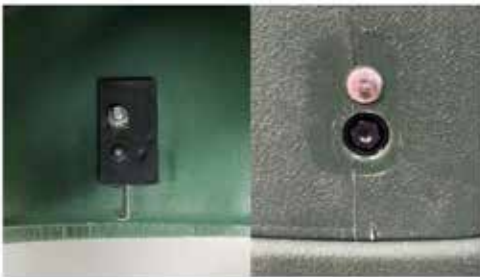
Figura 3: La ubicación del mecanismo de autobloqueo en los pedestales de fibra GOAT se encuentra en el lado izquierdo de la unidad del pedestal.
