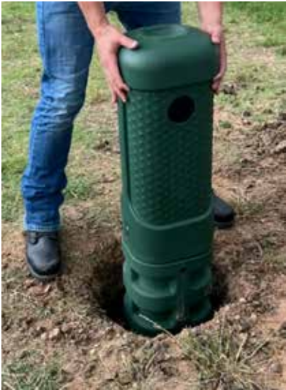
Figura 6: Bajada del pedestal de fibra al orificio para su instalación.
