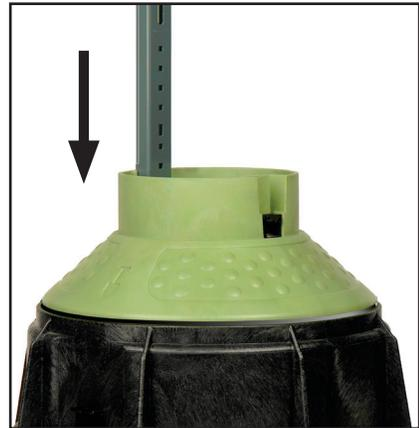
Coloque el faldón de tierra del pedestal HRP en la bóveda HRV asegurada e instale el cierre de empalme
