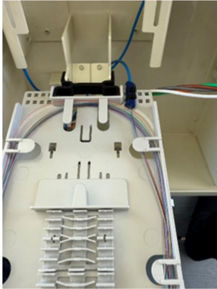
13. Una vez fijados los tubos protectores activos a la bandeja, enrolle los tubos protectores restantes en la cesta de cables sueltos y fíjelos con una brida.
