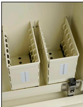
El módulo divisor SMFH de 16 ranuras tiene capacidad para múltiples tipos de configuraciones de divisor, desde 1x2 hasta 1x64.
