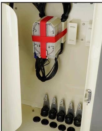
Los pigtails preinstalados se enrutan directamente a las bandejas de empalme universales (UST), que protegen los empalmes de cables de fibra única o de cinta. Se pueden añadir bandejas adicionales para facilitar la expansión.
